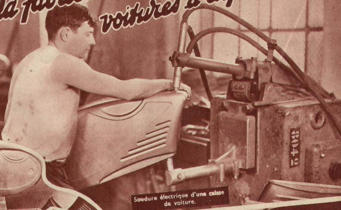
Soudure électrique d'une caisse de voiture.
